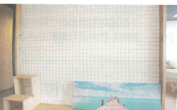
▲日本エムテックス(東京都世田谷区)の「エッグタイル」を貼り付けた。調湿機能を持つ
